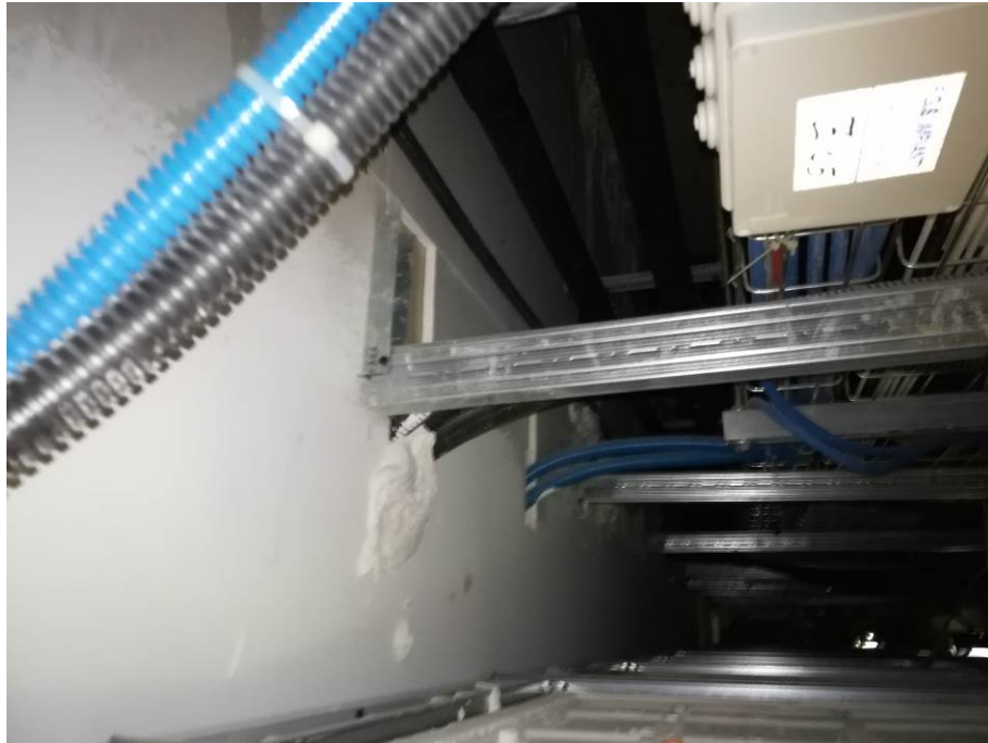
Intervento compartimentazione passaggi impiantistici
