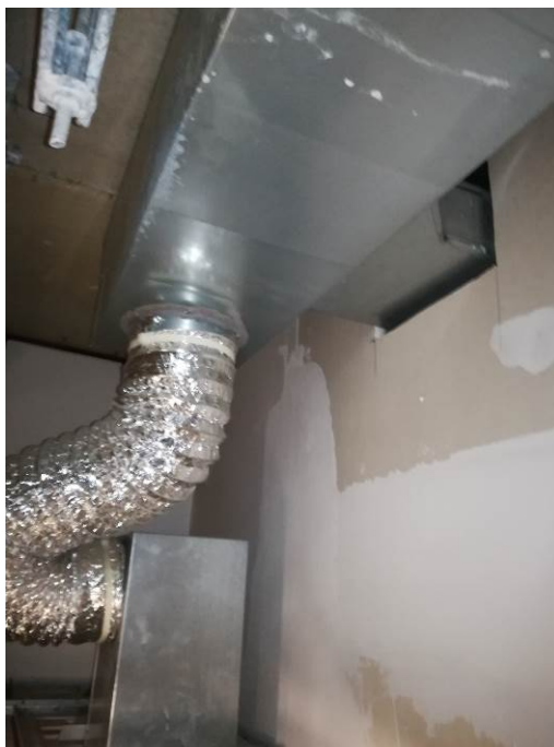
Intervento installazione serrande tagliafuoco
