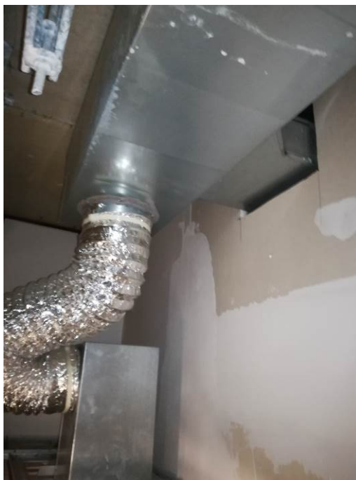
Intervento installazione serrande tagliafuoco
