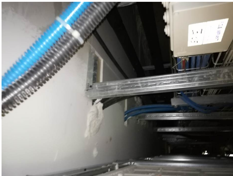
Intervento compartimentazione passaggi impiantistici
