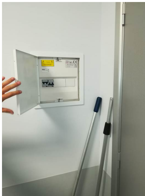
Intervento di compartimentazione del quadro elettrico del locale
